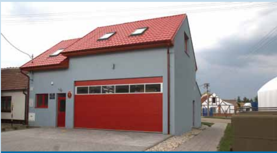
Hasičská zbrojnice v Ladné po rekonstrukci.
