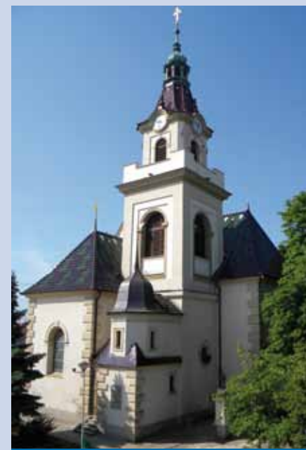
Oprava fasády věže byla dokončena v r. 2010.
