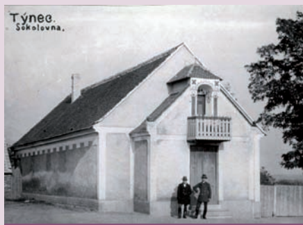
Budova místní sokolovny v r. 1927
