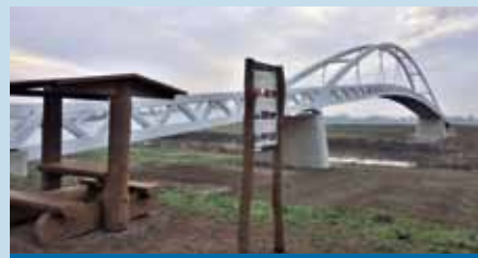
Nový most přes řeku Moravu
