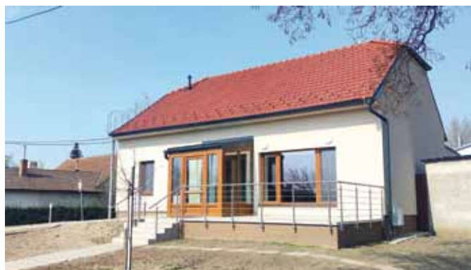
Špitálek po rekonstrukci
