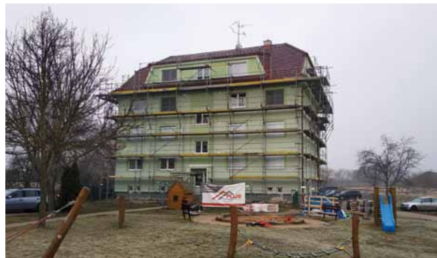
Rekonstrukce bytového domu Na Hrázce
