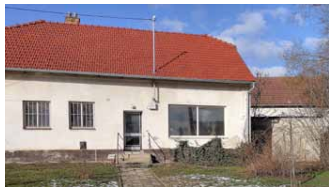
Špitálek před rekonstrukcí
