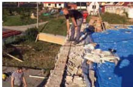
Opravy poškozených domů po tornádu
