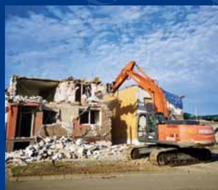
Demolice rodinného domu na ulici Hlavní v Hruškách
