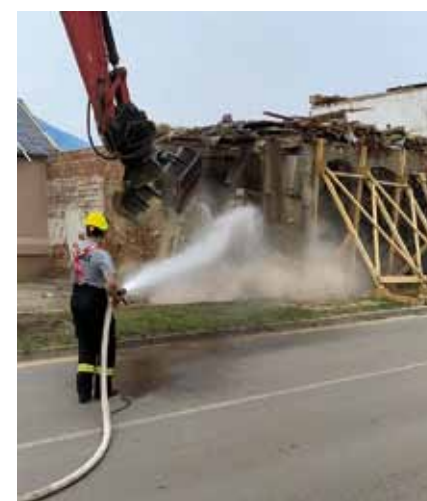
Demolice objektu v Mor. Nové Vsi
