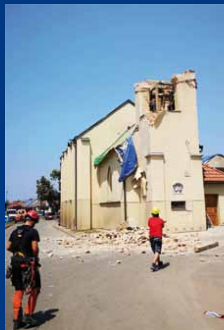
Částečná demolice věže kostela sv. Bartoloměje v Hruškách
