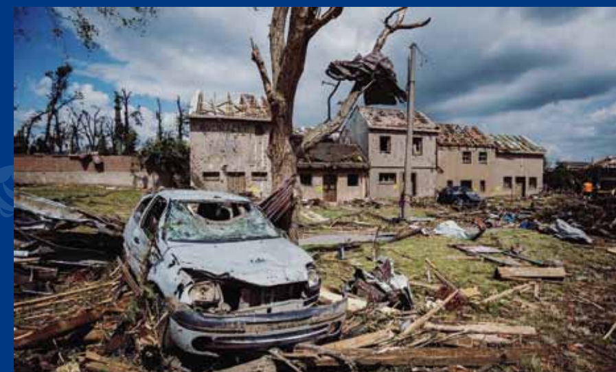
Škody po tornádu v obci Mikulčice
