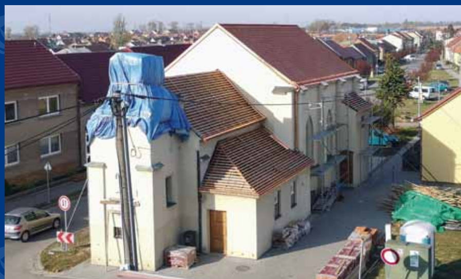
Částečně opravená střecha kostela sv. Bartoloměje v Hruškách
