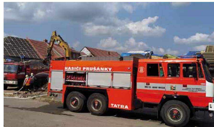
Hasiči z naší obce pomáhali při demolicích
