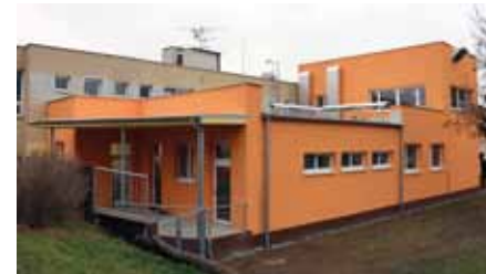
Přístavba mateřské školy, foto: P. Lorencová
