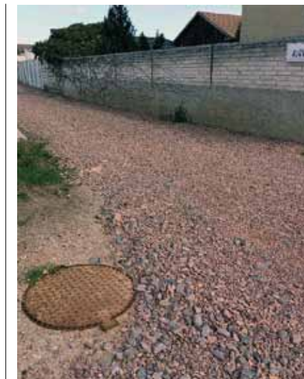
Kanalizace v Uličce v Ladné
