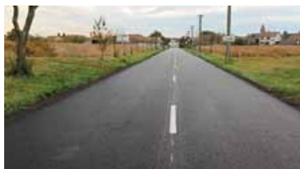
Nový povrch vozovky příjezdové komunikace do obce Ladná
